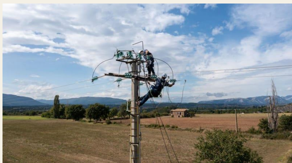
Recyclage des poteaux béton confié à la société SRB à Fos-sur-Mer.
