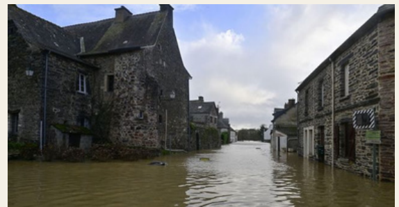
Une bonne partie des habitations du centre de Guipry-Messac (Ille-et-Vilaine) se retrouve sous l'eau, en juin 2024
